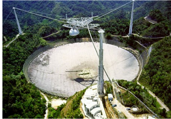
Figura 17. Ejemplo de dos radiotelescopios. A la izquierda las enormes antenas de más de 30 metros de diámetro del VLA (Very Large Array). A la derecha el radio telescopio "monolítico" más grande del mundo, el radiotelescopio de Arecibo con un objetivo "inmóvil" de 300 metros de diámetro.
